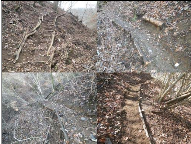
作業経路の補修 絶え間ない補修で経路を維持
